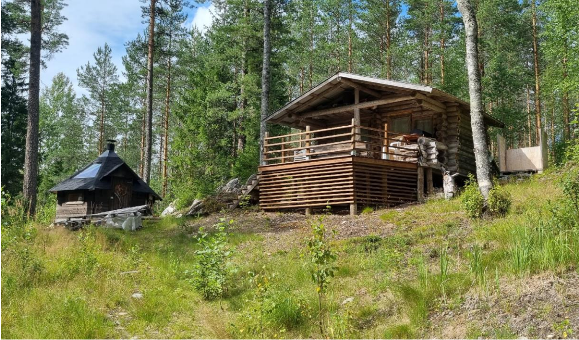
Kuva 18. Heinäjoen varressa tilalla 10:49 oleva rakennuspaikka, joka poistuu kaavasta. Rakennukset on purettava.
