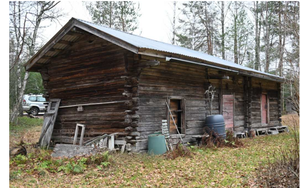
Kuva: Talo näyttää siltä, kuin se olisi osa pidemmästä rakennuksesta. Aittarivi on koottu kahdesta pitkänurkkaisesta aitasta ja hirsiseinäisestä väliköistä. Hirsisauna on tehty vanhoista hirsistä, pikkuaitta ehkä vanhan saunan hirsistä
