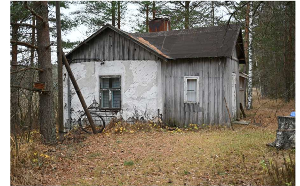
Kuva: Rantalehdon pienasumus (1920 rhr), jossa hirsiseinät vuorattu rappauksella. Kiinteistön rannassa on 1990-luvun lopun pyöröhirsinen rantasauna.
