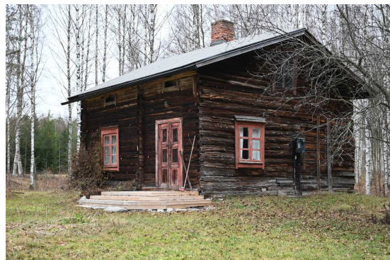
Kuva: Talo näyttää siltä, kuin se olisi osa pidemmästä rakennuksesta. Aittarivi on koottu kahdesta pitkänurkkaisesta aitasta ja hirsiseinäisestä väliköistä. Hirsisauna on tehty vanhoista hirsistä, pikkuaitta ehkä vanhan saunan hirsistä
