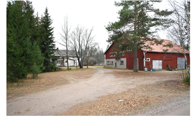
Kuva: Kokkopalon vanha talo (1881 rhr) on uudistunut ulkoasultaan korjauksissa ja laajennuksissa. Betonitiili- ja puurunkoinen karjasuoja.
