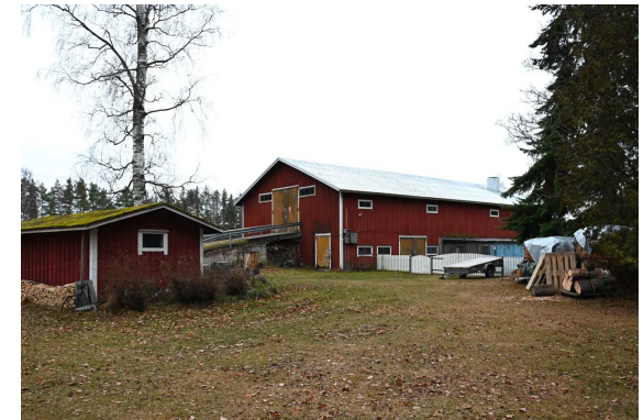
Kuva: Betoni- ja lautarakenteinen karjarakennus.
