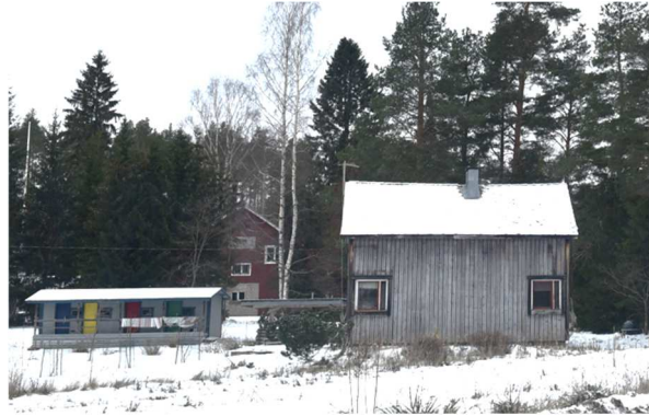
Kuva: Ojalan talossa on kulmaikkunat (1950 rhr).
