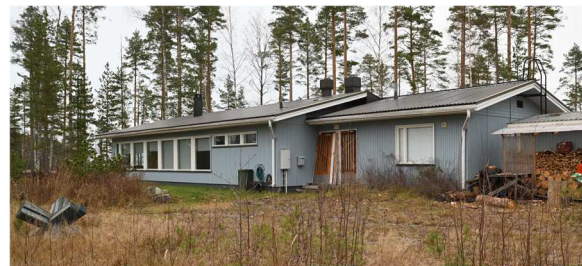
Kuva: Lomakodin aikainen ruokalarakennus (190 m 2 ).
