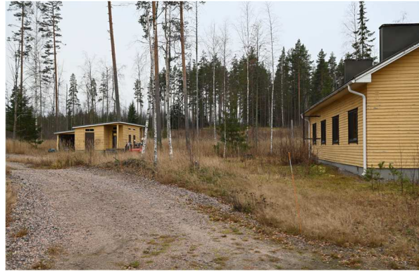
Kuva: Ulkorakennus ja entinen parakki.
