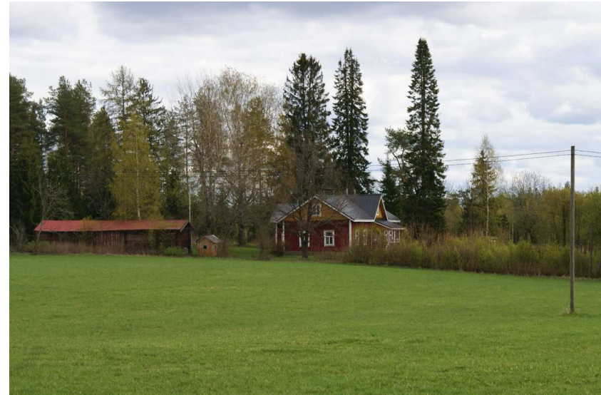
Kuva: Turulan talossa on vaalittu talonpoikaistyyliä ja pihapiirin vanhaa puustoa. Vuoraamaton hirsitalo (n. 1918) on 1996 tehdyn inventoinnin jälkeen maalattu punaiseksi keltaisin päätykolmioin. Huopakatteen tilalle on vaihdettu suoraprofiilinen peltikate. Pihapiiriin kuuluu hirsihuoneinen, lautaväliköllinen, riviaitta ja sauna.
