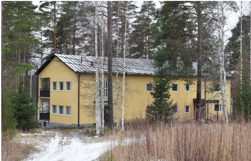
Kuva: Entisen B-sairaalarakennuksen julkisivuremontti on toteutettu rakennuksen pelkistettyä tyyliä vaalien. Yksityiskohdissa näkyy piestä tyylillistä kerroksisuutta. Toinen kuisti on tehty lisärakentamisen yhteydessä.
