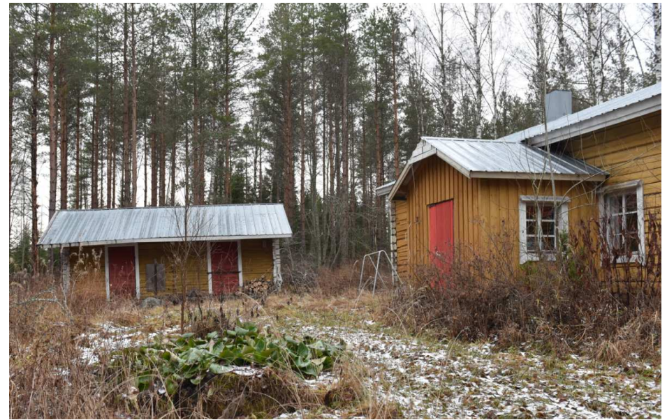
Kuva: Pariaitta ja päärakennus.
