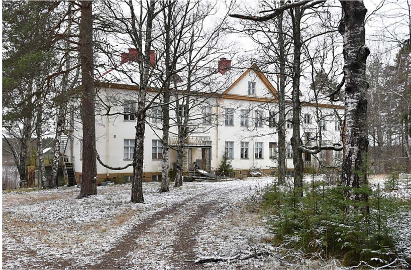
Kuva: Vanhan kunnalliskodin eduspihaan johtaa vanha koivukuja. Arkkitehtitoimisto Anttila & Klamin 60-luvun alussa suunnittelema peruskorjaus ei muuttanut julkisivuja.
