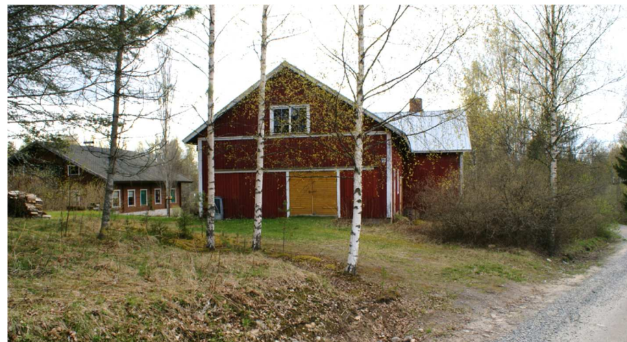
Kuva: Taustalla näkyvä hirsinen uudisrakennus on rakennettu 1980-luvun lopulla, sen jälkeen, kun vanha 1800-luvun sahanvalttarin puutalo oli tuhoutunut tulipalossa. Tien varrella on säilynyt entinen myllärintupa ja sen jatkoksi vinkkeliin tehty varasto.
