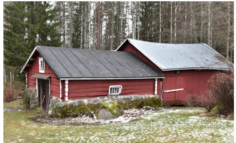
Kuva: Tallirakennuksessa alaosa on tehty ilmaraoillisenä luonnonkivimuurauksena ja yläosa pitkänurkkaisena hirsirakenteena. Jatkeena on lautaseinäinen sarani.
