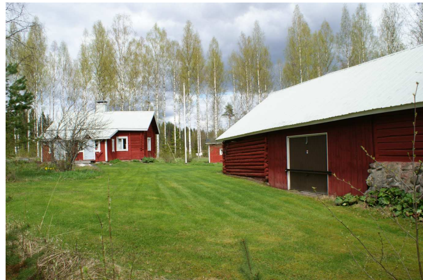
Kuva: Kissakosken tilan maalla on vuoraamaton hirsitalo ja kivi-hirsirakenteinen talousrakennus.
