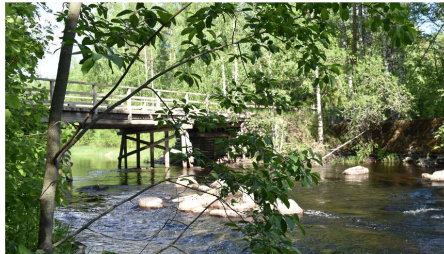
Kuva: Kuhakosken pääosin pyöreistä puista tehdyn palkkisillan pituus on noin 20 m. Sillan välituet ovat rivi pystypaaluja, joita sitoo kahta puolen viistotuki sekä rivin päissä vinopaalu. Silta on kunnostettu 2004.
