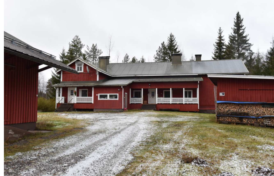
Kuva: Jokimutkassa sijaitsevan entisen kansakoulutalon ulkomuodossa on korjausten tuomaa kerroksisuutta (kuisti-, verhouk- ja ikkunamuutoksia). Rakennus on ollut yksityisomistuksessa jo puolen vuosisadan ajan. Piirtänyt savonlinalainen Kustaa Laukkanen 1908. Käsityöluokka ja opettajan asunto tehtiin vanhasta hirsirakennuksesta. Nykyinen talousrakennus on rakennettu 1956 vuoden paikkeilla.
