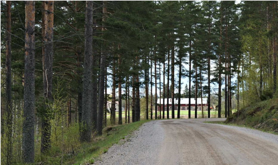
Kuva: Ranta-Matin karjarakennus on tienäkymän päätteenä kaakosta kylälle tullessa.
