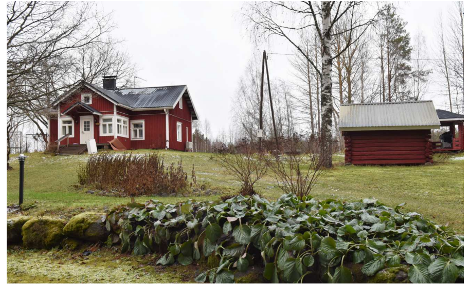
Kuva: Jokirannan asuinrakennus on peruskorjattu (laajennettu ja korotettu) sen 1800-luvun lopulle palautuva kansanomaisen rakennustyyli huomioon ottaen. Pihapiirin pieni päätyovellinen hirsiaitta on kertoman mukaan tehty puretun tuulimyllyn hirsistä.
